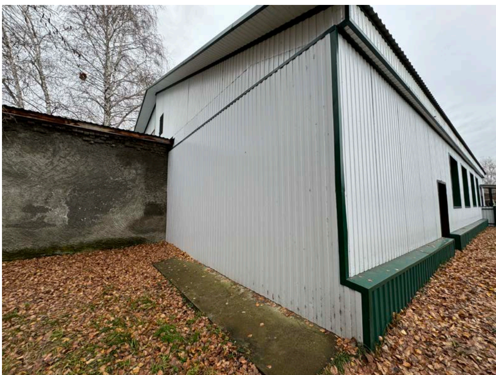
Отсутствие деформационных повреждений строительных конструкций. Состояние фасадов здания
