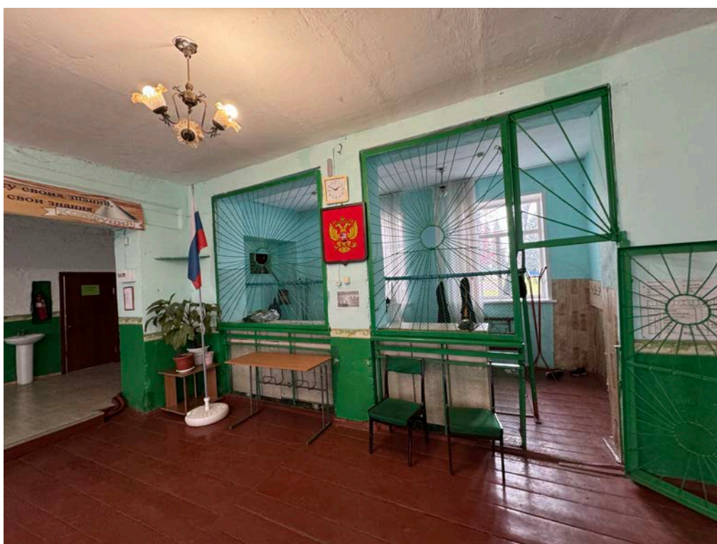
Отсутствие деформационных повреждений строительных конструкций. Состояние отделочных покрытий
